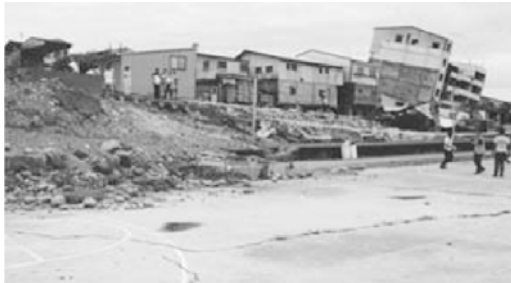
صفحه گسل با تغییر شکل عمودی قابل ملاحظه است، زلزله منطقه چی‌چی تایوان سال ۱۹۹۹
