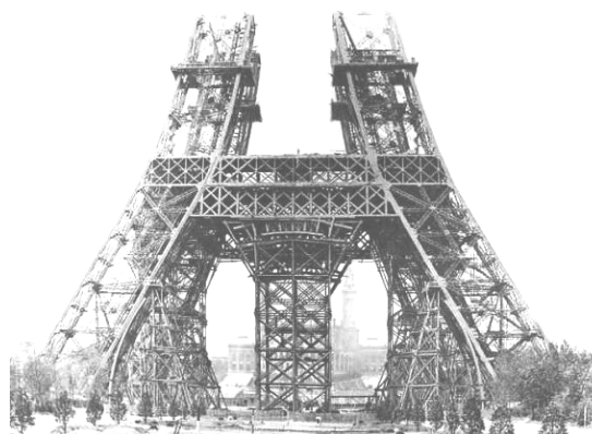
«گوستاو ایفل در ساخت برج ایفل از میله‌های فشاری متقاطع همانند ساختاری که در استخوان ران وجود دارد استفاده کرد.»
