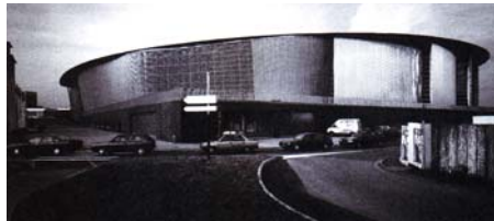
رم کولهاس، ساختمان همایش لیل، فرانسه، (۱۹۹۴)، چشم‌انداز کلی، ساختمان در مرکز تاریخی حاشیه شهر لیل قرار گرفته و از سه بخش اصلی تشکیل شده است: ۱- سالن کنسرت، ۲- فضای مرکزی، ۳- مرکز نمایشگاهی.
